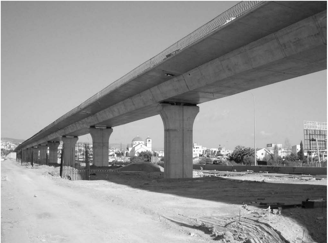
Figura 1. Viaducto de Limassol, en construcción.
