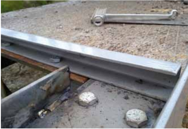
Fig. 18. Colocación de los perfiles con sección en C para atornillado de las chapas de las aceras
