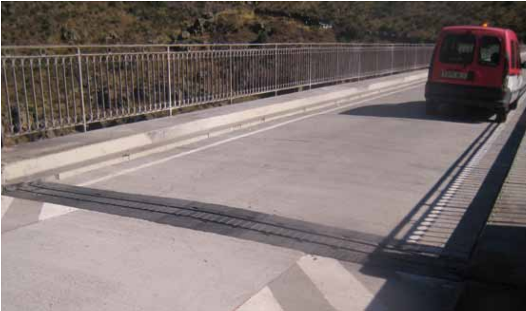
Fig. 26. Aspecto final de la calzada sobre el puente
