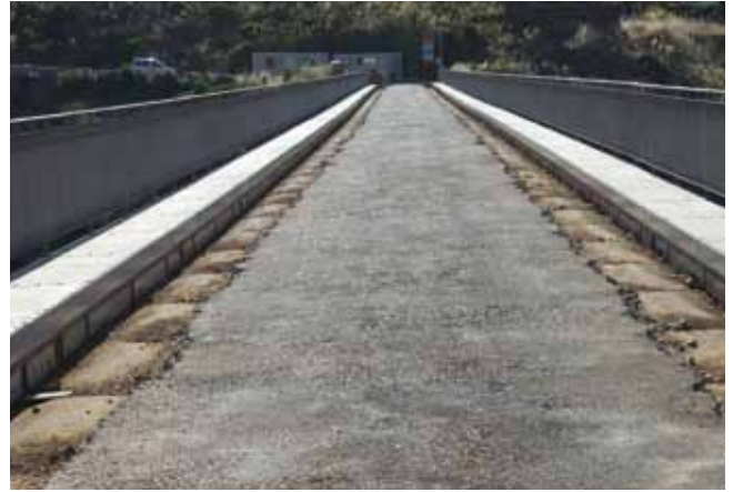
Fig. 19. Aspecto del tablero una vez concluida la rehabilitación de las vigas principales
