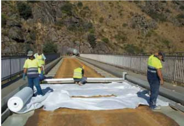
Fig. 22. Colocación de geotextil
