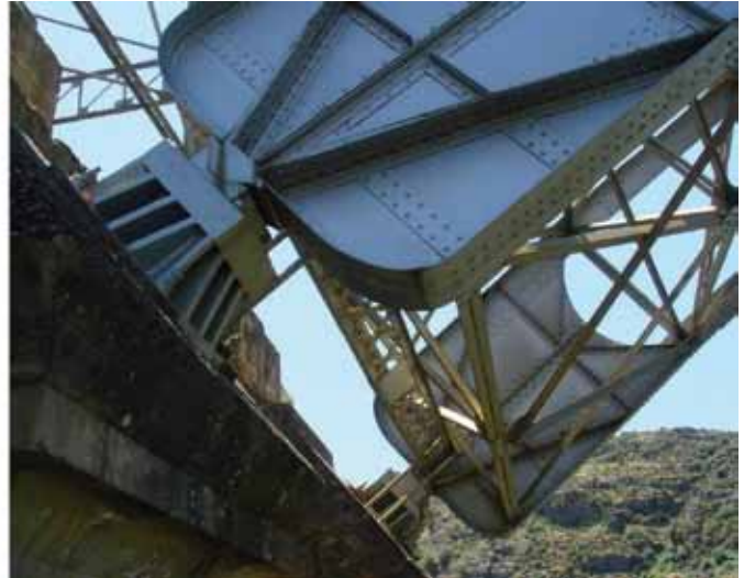
Fig. 3. Articulación en arranque de arco
