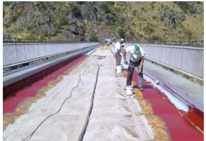
Fig. 21. Lámina de resina de poliuretano (2 Capas). Imprimación + revestimiento
