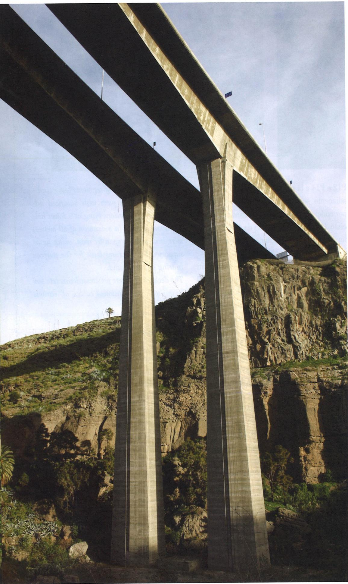
due carreggiate stradali e si dirama, nelle zone di biforcazione, in una trave a cassone doppio che a sua volta si dirama in due travi a cassone monoconnesso ognuna alloggiante una carreggiata stradale.
